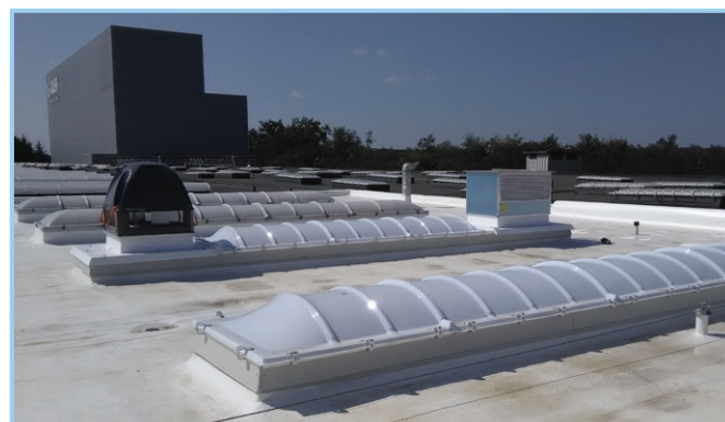
Stabilimento Caleffi - Borgomanero (NO)
